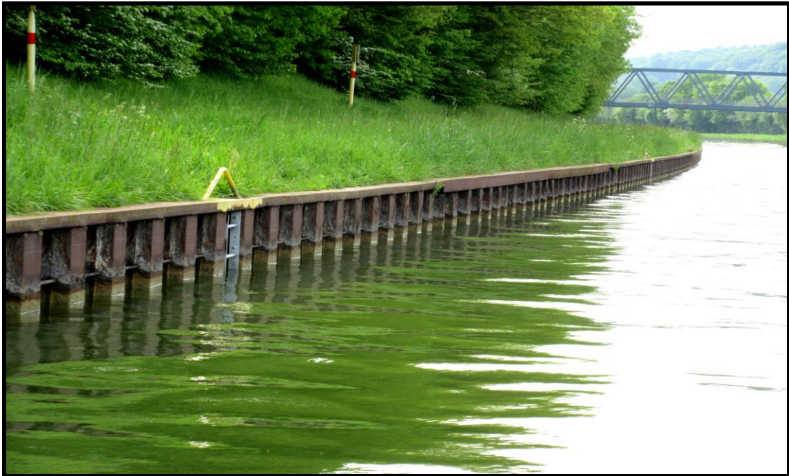
Abbildung: Uferstrukturen Mittellandkanal, Bereich Probestelle 4
