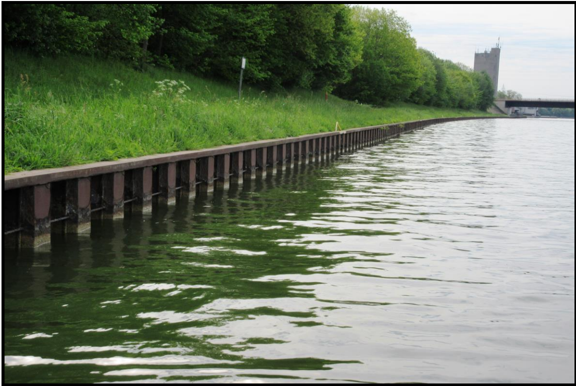
Abbildung: Uferstrukturen Mittellandkanal, Bereich Probestelle 1
