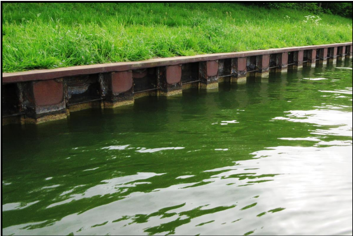
Abbildung: Uferstrukturen Mittellandkanal, Bereich Probestelle 2
