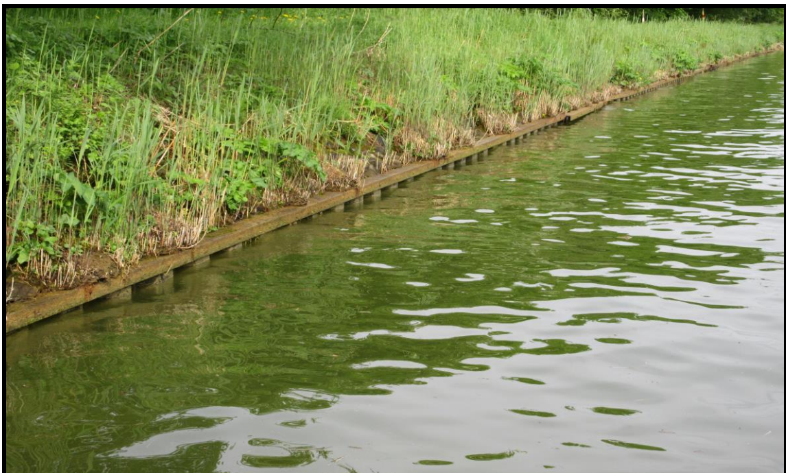
Abbildung: Uferstrukturen Mittellandkanal, Bereich Probestelle 5
