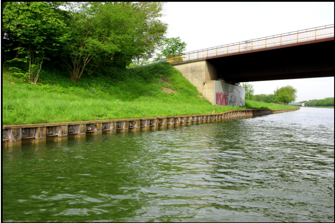
Abbildung: Uferstrukturen Mittellandkanal, Bereich Probestelle 6
