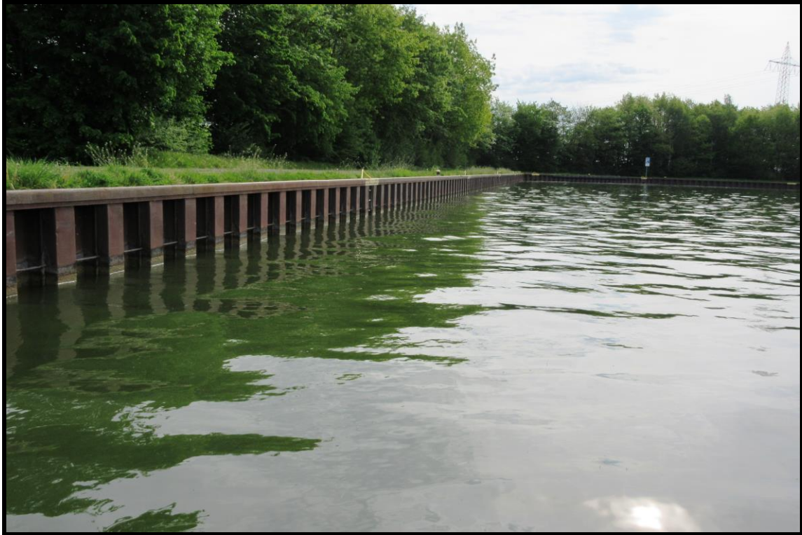
Abbildung: Uferstrukturen Mittellandkanal, Bereich Probestelle 3
