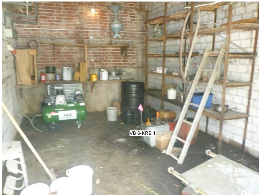
Abb. 13: Verdachtsbereich 6 in Blickrichtung Südosten. (Gebindelager, Lage KRB VB 6 – KRB 1)
