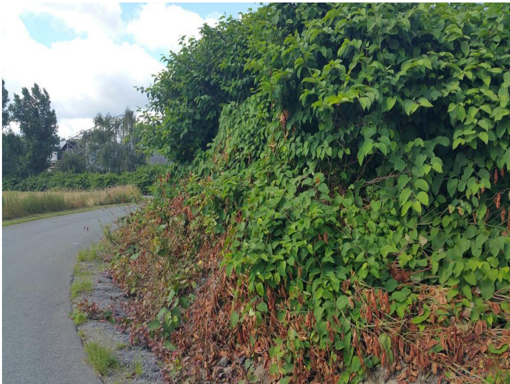
Abb. 10: Verdachtsbereich 4 an der Straßenseite in Blickrichtung Süden.
