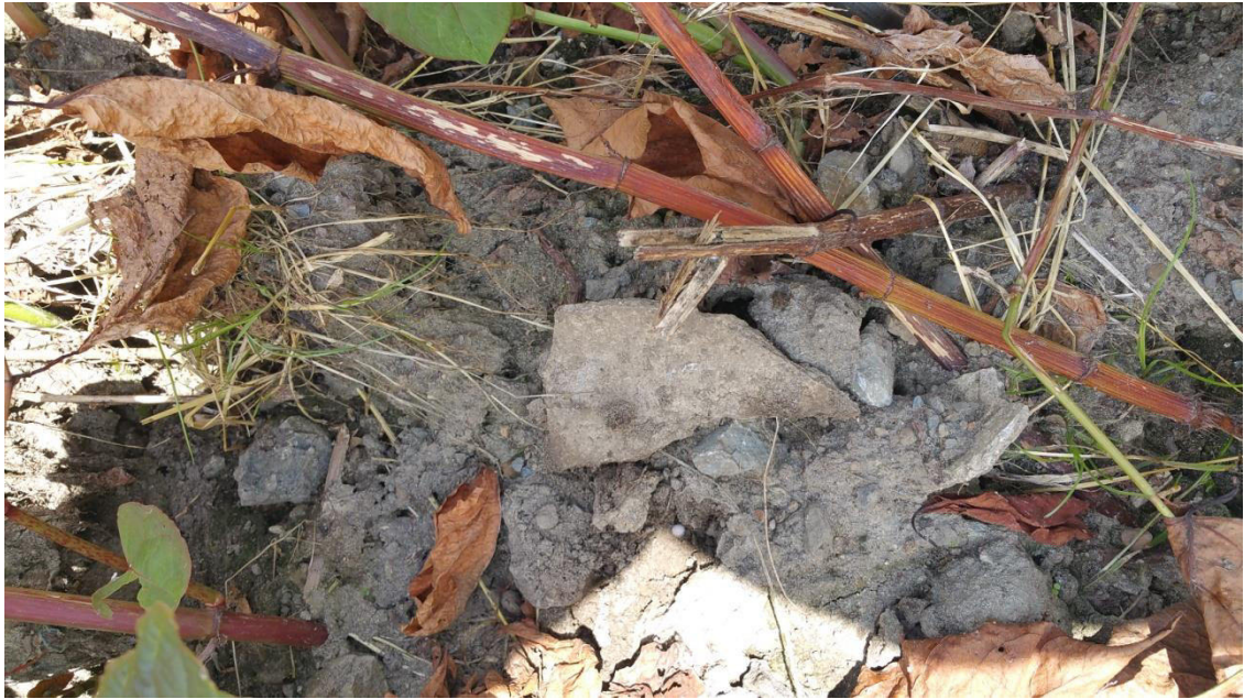
Foto: Fundstelle pot. Asbestzementbruchstücke im Randbereich zur Straße (ungefähre Lage: Probenahmestelle 5/6)
